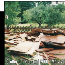
Großer Umbau / Juni 2000 - März 2001
